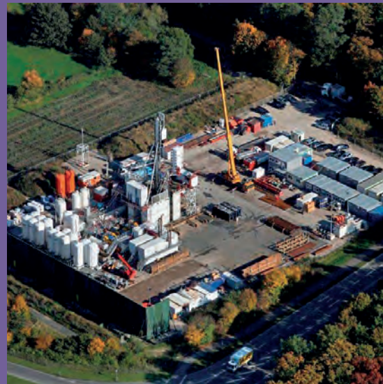
Beispiel eines Bohrplatzes während der temporären Bohrphase.
